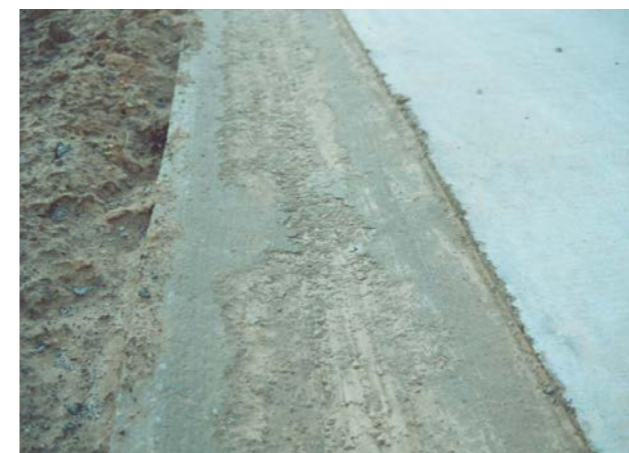
Voorbeelden van vers beton dat aan vorst werd blootgesteld: - straatgoot en boorkern genomen in het beton; het beton heeft niet langer een compacte structuur
