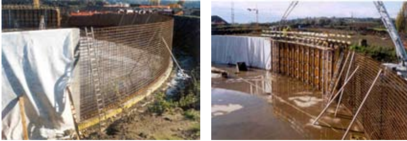
Fig. 7 a, b – Betonwand na ontkisting beschermd met behulp van een zeil
