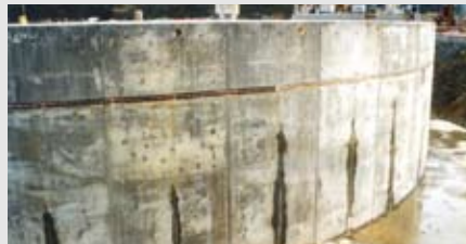
Fig. 13 – Scheurvorming door verhinderde krimp in een betonwand. De eerder aangelegde funderingsplaat belet dat het beton vervormt door thermische samentrekking
