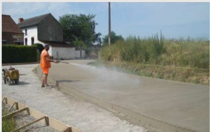
Verstuiven van een curing compound op het oppervlak van een pas aangelegde betonweg.
