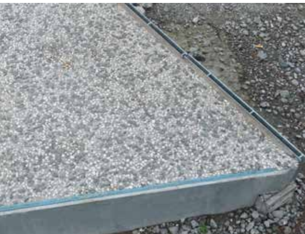
Op maat gemaakt gegalvaniseerd stalen profiel als werkvoeg (Herstal, Pôle Marexhe)
