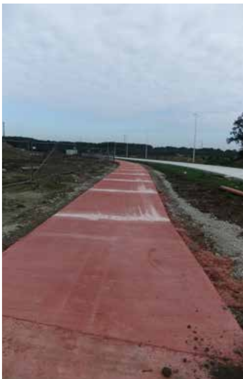
Langwerpige betonplaten voor een fietspad
