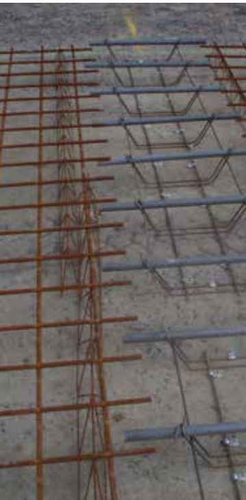
Combinatie van wapeningsnet en deuvels
