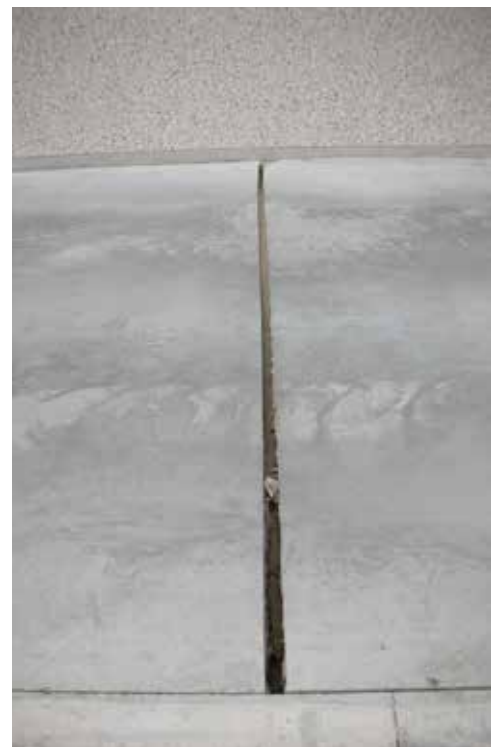
Openstaande voeg door glijding van het beton over een plastic folie (foto Anne Beeldens)
