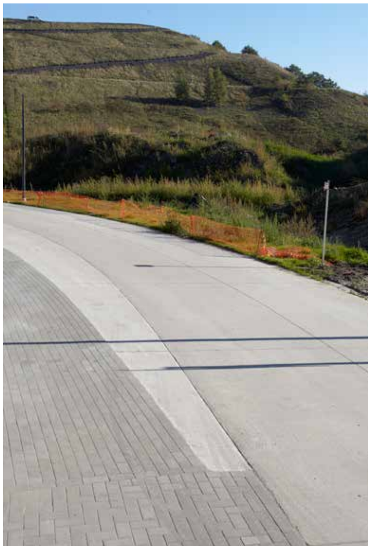
Nieuw aangelegde weg in platenbeton in combinatie met parking. Bemerkt de rijbaanverbreding in de bocht. © A.Nullens
