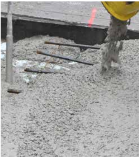
Voorbeelden van ongeschikte deuvels (corrosie, bramen) en deuvelstoelen (doorbuiging onder beton, verplaatsing deuvels)
