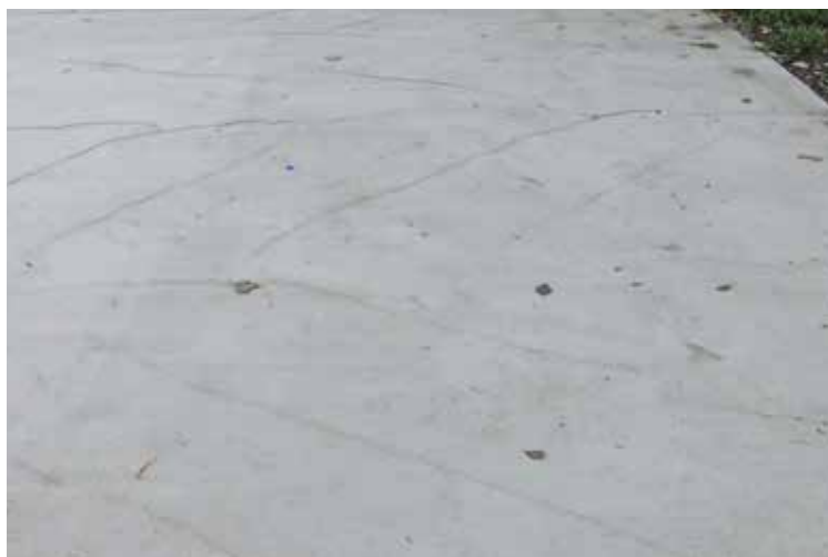
Grillige plastische krimpscheuren ten gevolge van een onvoldoende bescherming van het verse beton
