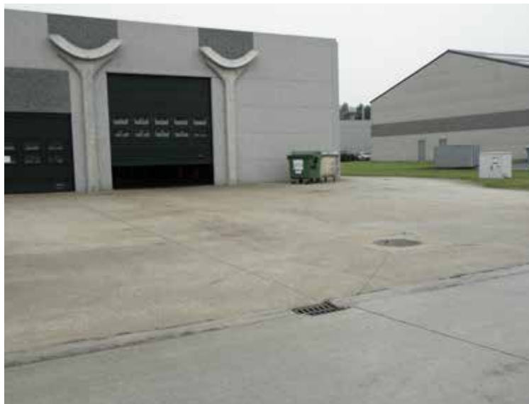
Platenbeton voor de rijweg en buitenverharding in een industriezone
