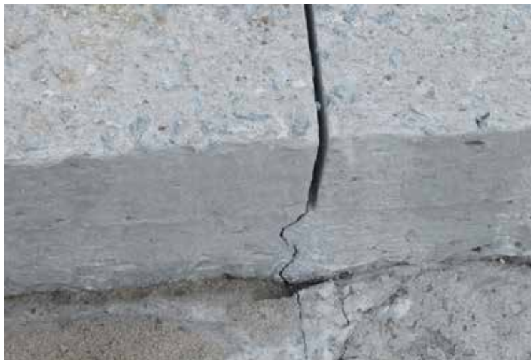
Zaagsnede die gewerkt heeft als scheuraanzet
