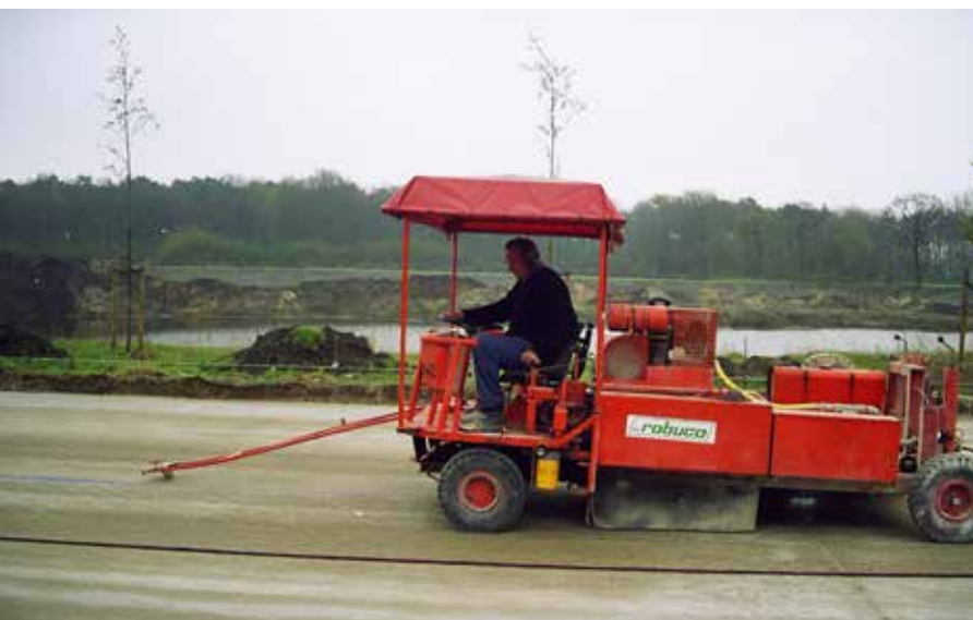
Zaagmachine voor het zagen van de langse buigvoeg
