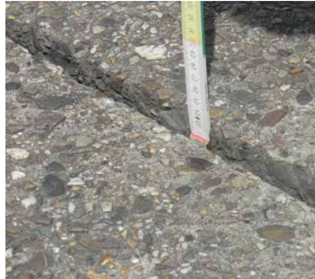
Trapvorming ter hoogte van een dwarse voeg
