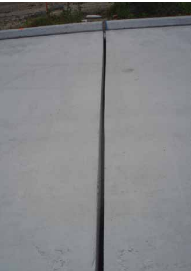
Uitgezaagde uitsparing voor plaatsing uitzetvoeg
