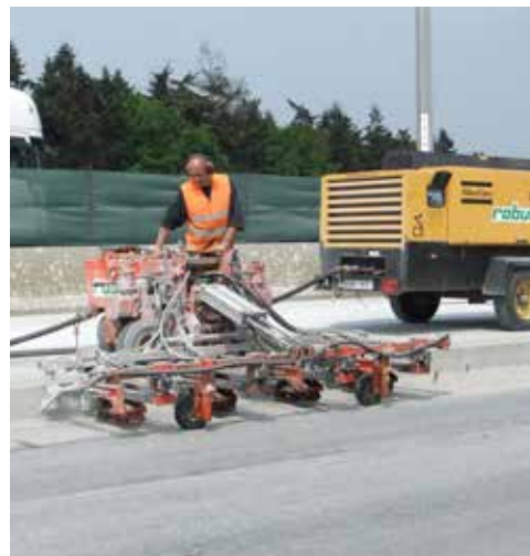
Boren van gaten voor ankerstaven
