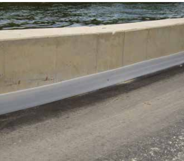
Voorbeelden van isolatievoeg langsheen een watergreppel en een opstaande wand (Foto's : Kebro – project voor Dienst voor de Scheepvaart te Bree)
