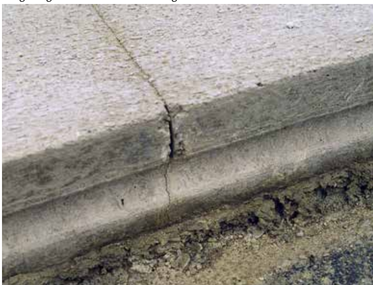
Langsvoeg met hol- en dolverbinding
