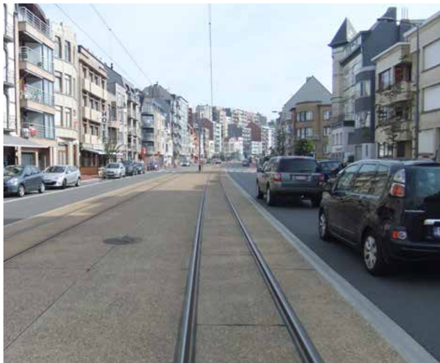
Trambaan te Blankenberge met smalle betonplaten tussen en langs de rails
