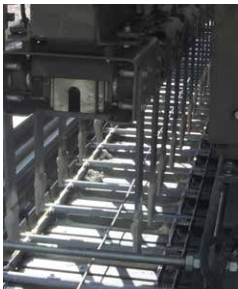
Intrillen van de deuvels in het verse beton
