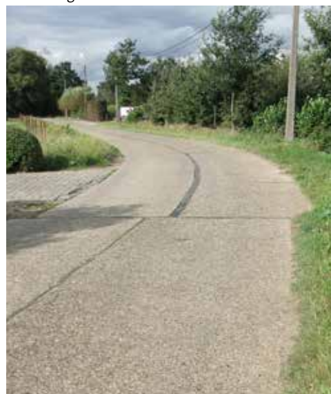
Verschuiven en opengaan van de langsvoeg in afwezigheid van ankerstaven
