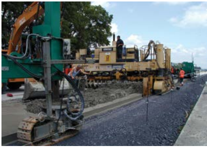
Estaimpuis : aanleg van het tweelaags doorgaand gewapend beton
