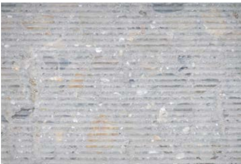
Langs fijngroeven van het verse beton in Illinois, U.S.
