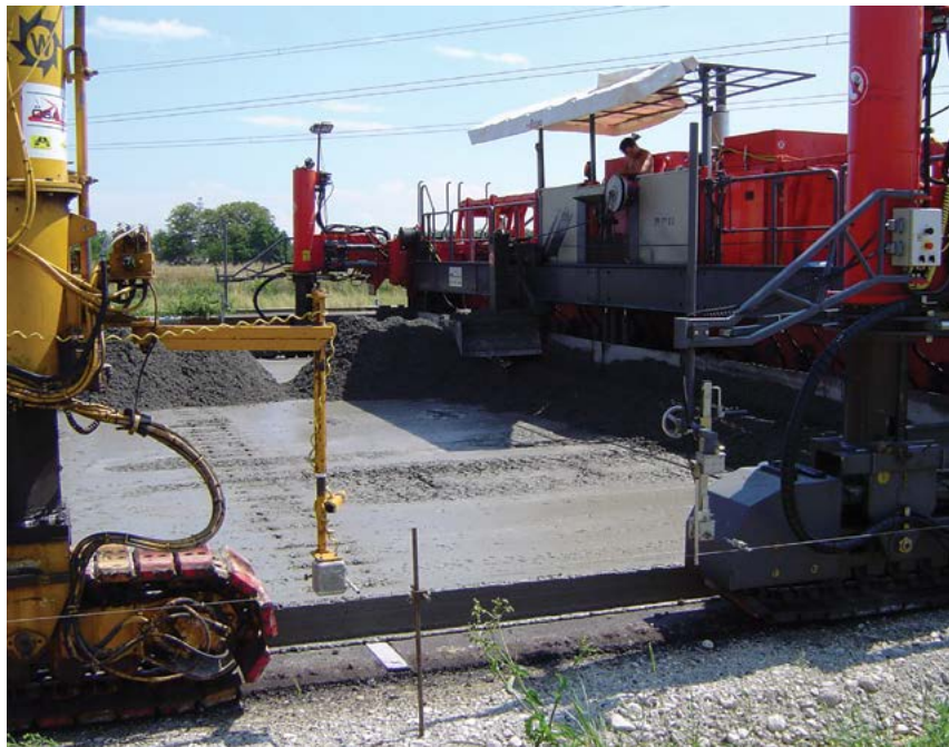
Twee glijbekistingmachines die een tweelaags platenbeton aanleggen op de A1, nabij Wenen.
