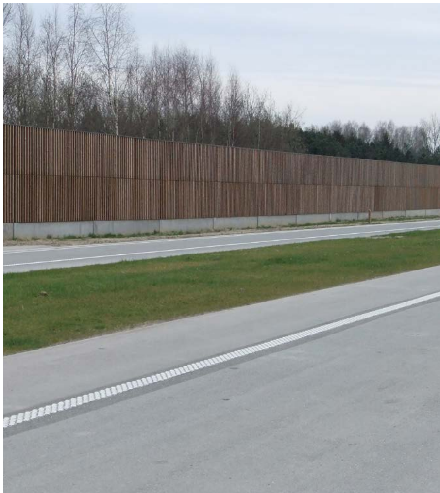
Geluidsarm tweelaags beton in combinatie met geluidswanden op de N19g Geel-Kasterlee, nieuwe noord-zuidverbinding in de Kempen
