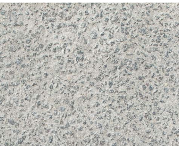
E17 De Pinte – Kruishoutem : eenlaags uitgewassen beton 0/20 Gemeten geluidsniveaus met CPX aan 80 km/u: 98,5 dB(A) voor vrachtwagenband en 99,1 dB(A) voor personenwagenband
