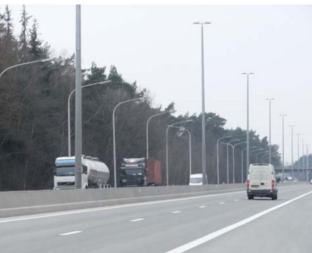
E313 Herentals-Grobbendonk : tweelaags uitgewassen beton met deklaag 0/6,3 Gemeten geluidsniveaus met CPX aan 80 km/u: 98,5 dB(A) voor vrachtwagenband en 98,5 dB(A) voor personenwagenband
