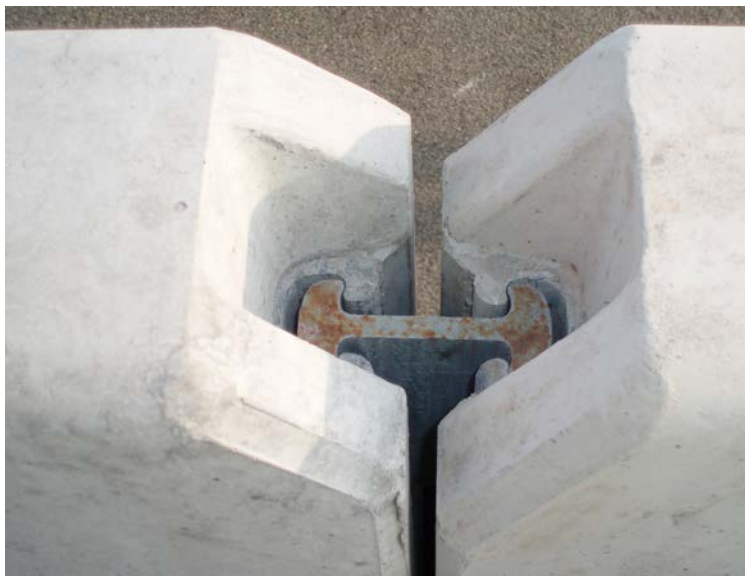
Detail van de koppeling tussen twee prefab elementen
