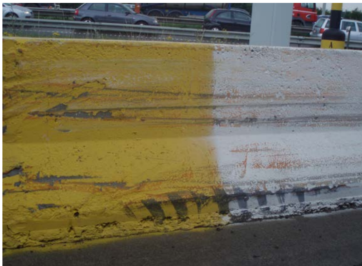
Bandensporen op een betonnen geleideconstructie na een of meerdere aanrijdingen
