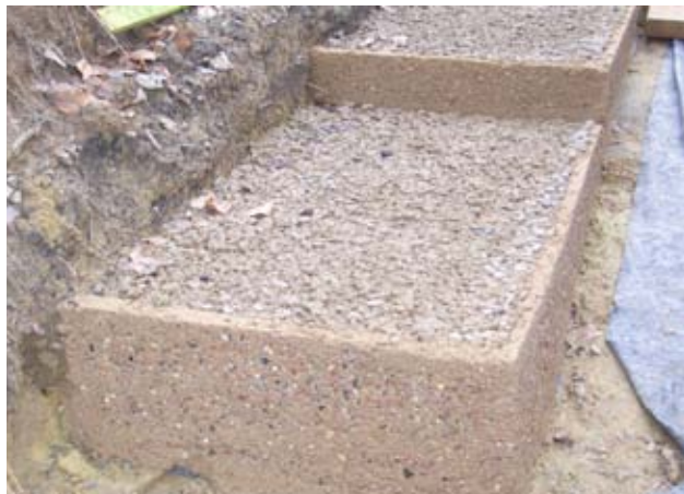
De Pinnebeekdreef te Watermaal-Bosvoorde vormt een toegangsweg tot het Zoniënwoud. Op het sterk hellende eerste stuk werd een verharding aangelegd in drainerend beton. Foto's tijdens de werken in het voorjaar 2006. Zie ook coverfoto. (© BIM)
