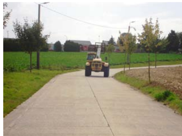
Gezien hun duurzaamheid en het feit dat er praktisch geen onderhoudskosten zijn, is het niet verwonderlijk dat sinds de jaren '50 beton wordt gekozen voor de bouw van landelijke en ruilverkevelingswegen. In België ligt het percentage landbouwwegen in beton tussen 50 en 60 %.
