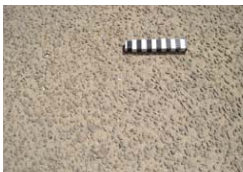
Uitgewassen gekleurd betonoppervlak.
