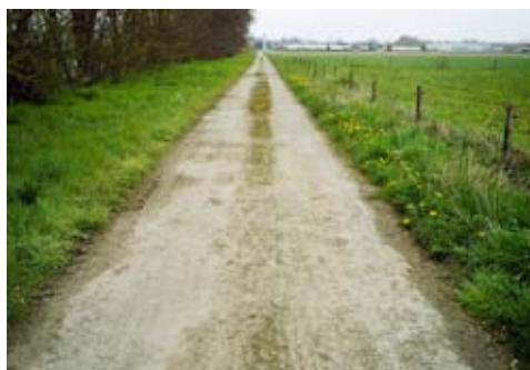
Weg in walsbeton te Diepenbeek, aangelegd in 1998. Rechts: dezelfde weg in 2011.
