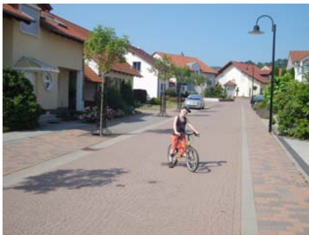
Betonproducten bieden vele creatieve mogelijkheden, dankzij het aanbod aan vormen en kleuren. De straat is een speel- en ontmoetingsruimte geworden.
