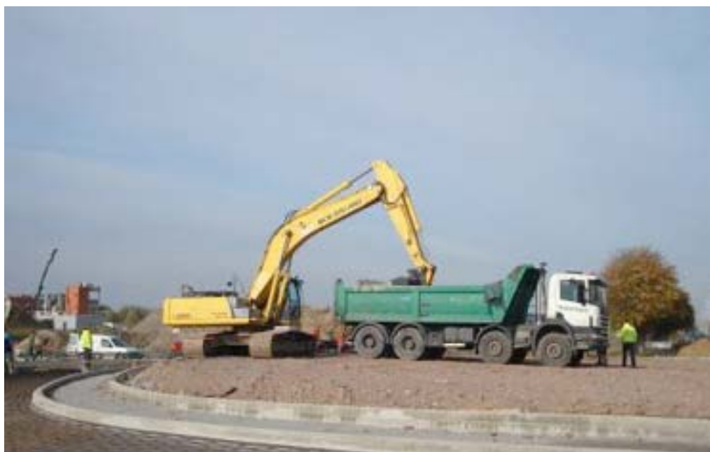
Aanvoer van beton via het middeneiland.
