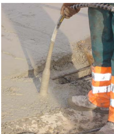
Betonnering van de aanzetten
