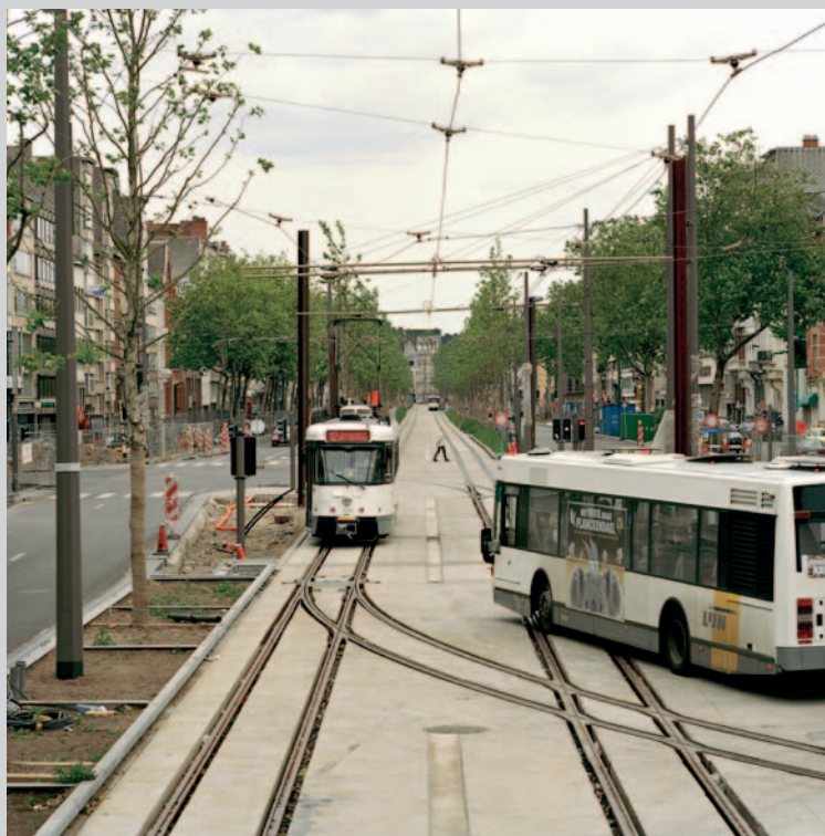
Voorbeeld van gecombineerde trambusbaan op de Leien te Antwerpen
