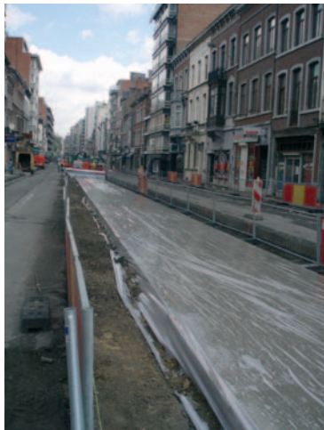
Onmiddellijk na het betonneren wordt een bindingsvertrager verstoven op het betonoppervlak. Die verhindert de uitharding van de cementmelk aan het oppervlak.
