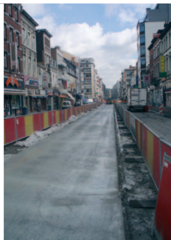
Na het zagen wordt de cementmelk van het betonoppervlak met water weggeborsteld. Zo ontstaat een uitgewassen oppervlak met heel goede eigenschappen van stroefheid en rolgeluid. Dankzij de kwaliteitsvolle samenstelling van wegenbeton kan de busbaan al vier tot zeven dagen na aanleg in dienst worden gesteld, namelijk zodra de drukweerstand op boorkernen gemiddeld 40 MPa bedraagt.
