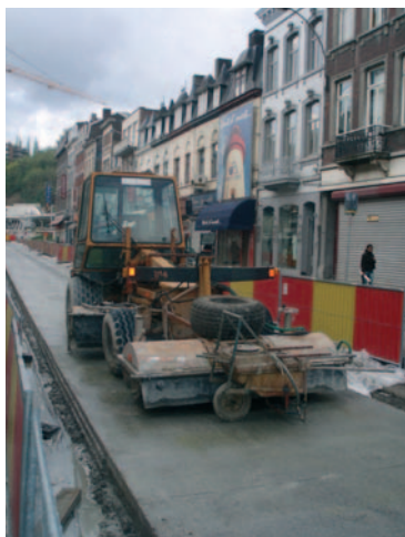
Na het zagen wordt de cementmelk van het betonoppervlak met water weggeborsteld. Zo ontstaat een uitgewassen oppervlak met heel goede eigenschappen van stroefheid en rolgeluid. Dankzij de kwaliteitsvolle samenstelling van wegenbeton kan de busbaan al vier tot zeven dagen na aanleg in dienst worden gesteld, namelijk zodra de drukweerstand op boorkernen gemiddeld 40 MPa bedraagt.
