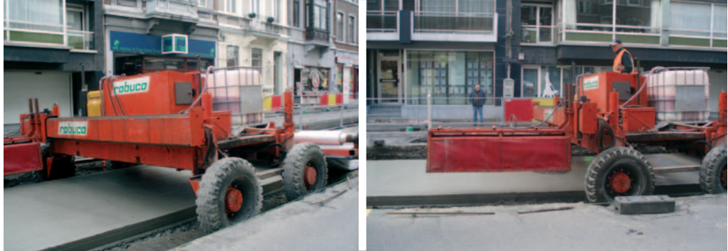
Onmiddellijk na het betonneren wordt een bindingsvertrager verstoven op het betonoppervlak. Die verhindert de uitharding van de cementmelk aan het oppervlak.
