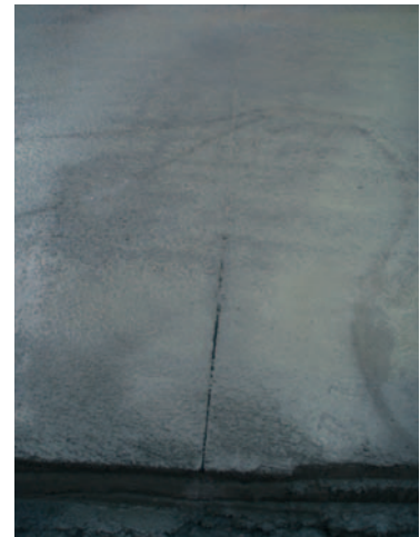
Onmiddellijk na het betonneren wordt een bindingsvertrager verstoven op het betonoppervlak. Die verhindert de uitharding van de cementmelk aan het oppervlak.
