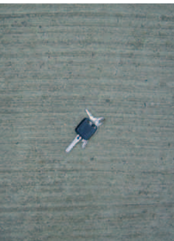
Oppervlaktebehandeling door eenvoudig bezemen: de meest toegepaste techniek.
