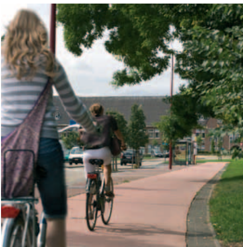
Fietspad in ter plaatse gestort beton
