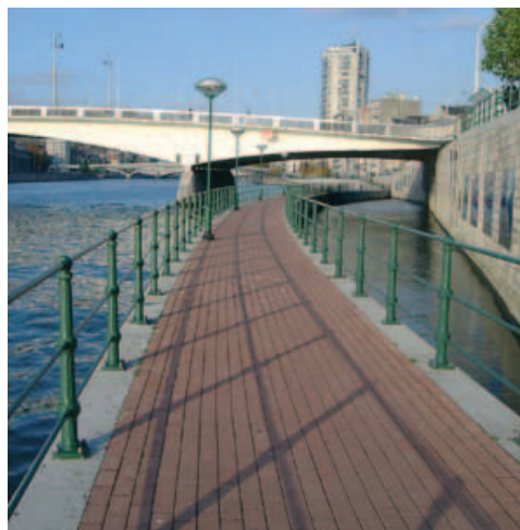
Fietspad in betonstraatstenen
