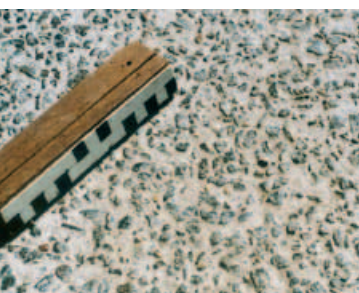
Oppervlaktebehandeling door uitwassen. De granulaten zijn zichtbaar. Het rijcomfort is zeer hoog.
