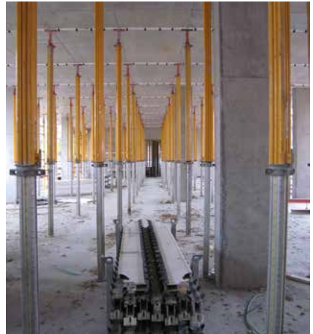
systeembekisting paddenstoelvloer
