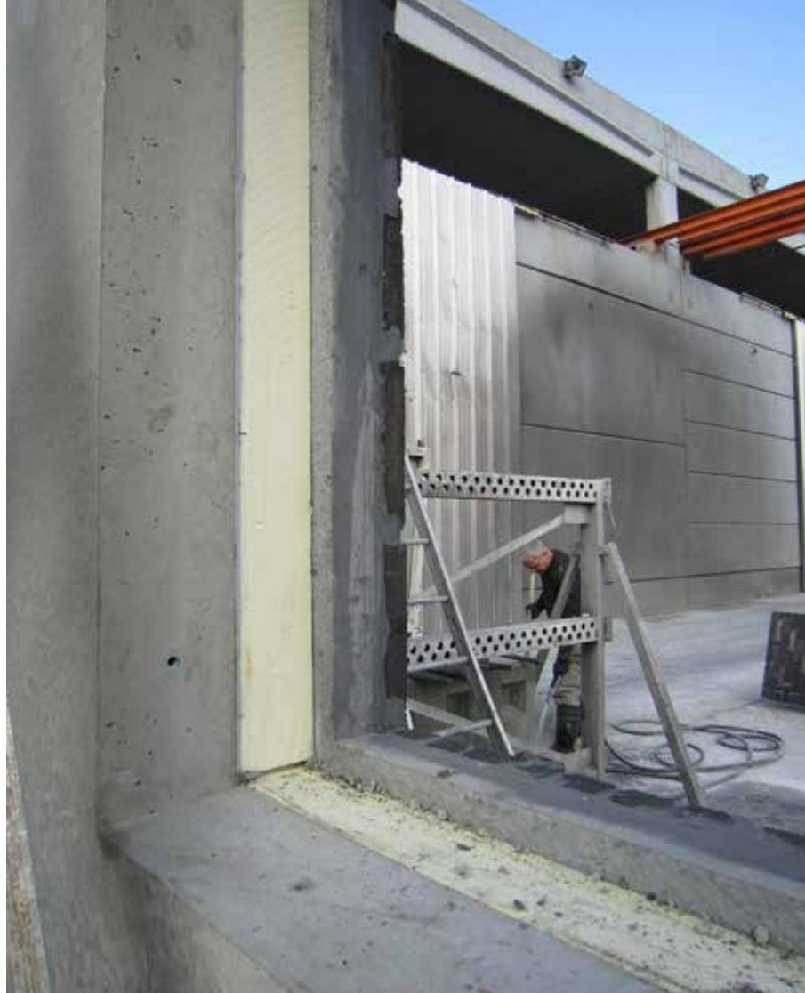
gevelpaneel met binnenblad in afgestreeken beton, isolatie en buitenblad met ingestorte baksteenplaketten
