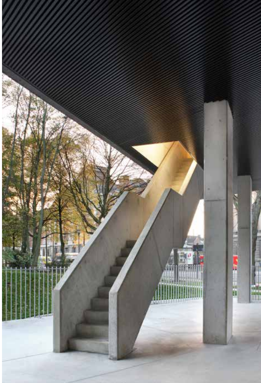
evacuatietrap als structureel en structurerend element in de ruimte
