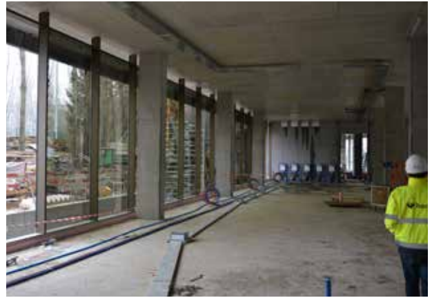
plaatsing gordijngewel uitgelijnd op de betonnen kolomstructuur
