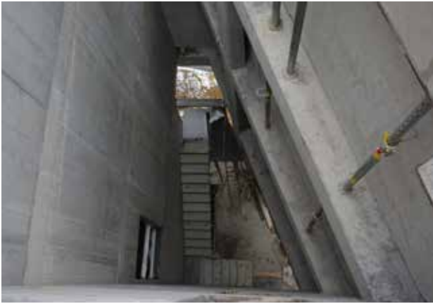
ruwbouw trappenhal oostgevel met prefab betonnen trapsledes
