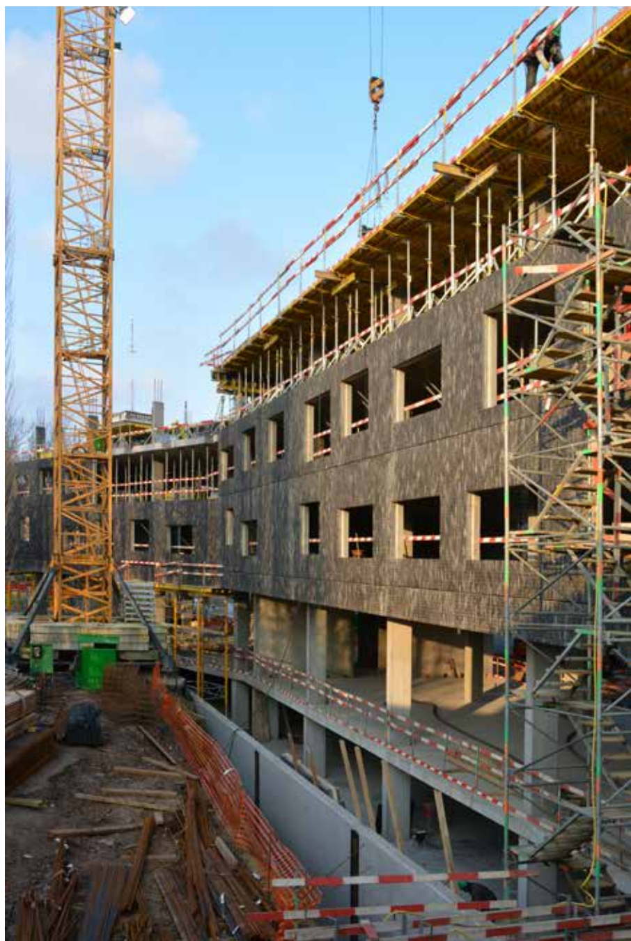
graduele opbouw van het betonskelet met invulling van de gevelpanelen
