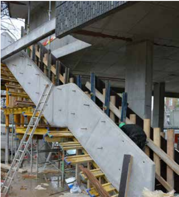
ter plaatse gestorte borstwering van de structurele trap aan de westgevel
