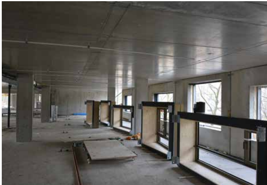
geprefabriceerde erkers klaar voor montage in de gevelpanelen
