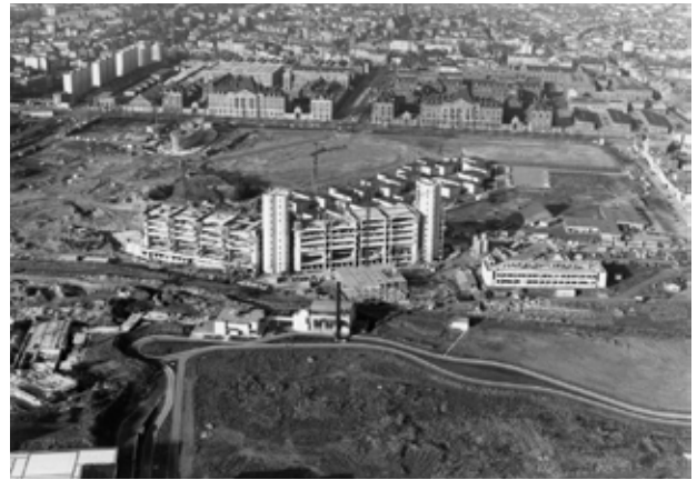
campus in aanbouw anno 1972 (collectie CAVA)
