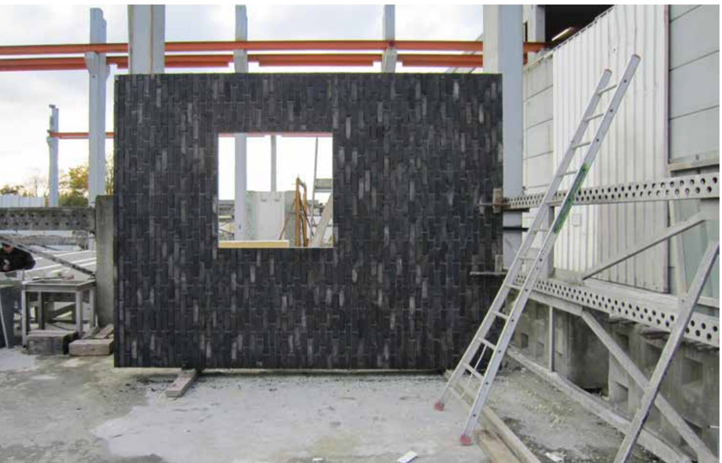
mock-up van gevelpaneel met uitlijning van plaketten rond raamopening
