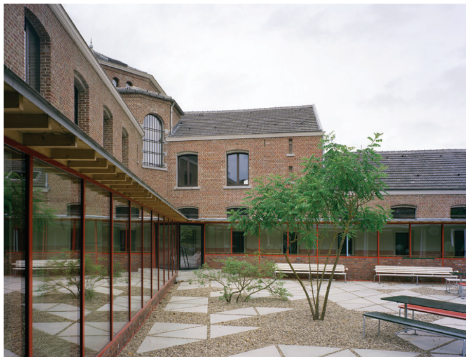
Tuin, cafetaria en koer tussen cellenvleugels met nieuw rondgangen
