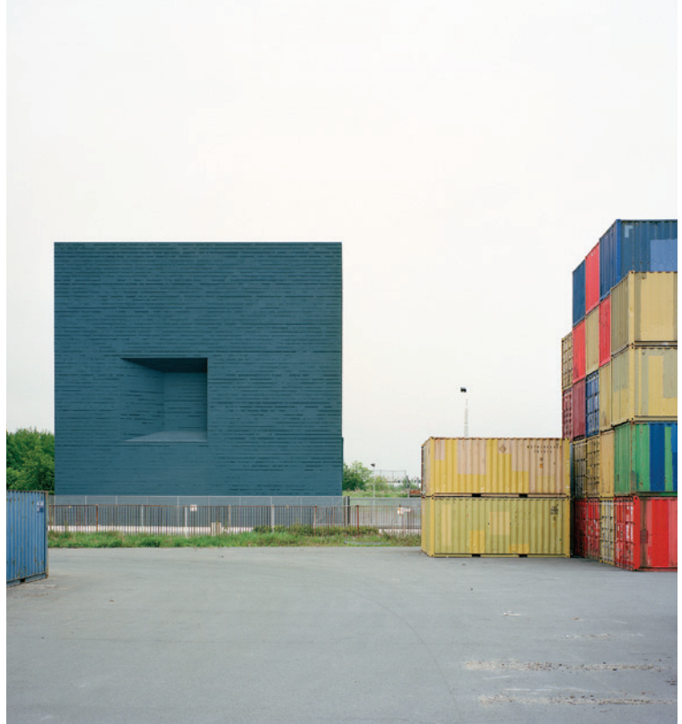
023 Petrol 150/15 kV onderstation Antwerpen
