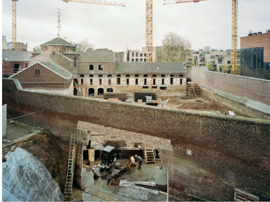
Werf Oude Gevangenis, doorbraak gevangensmuur voor verbinding met Faculteitsgebouw
