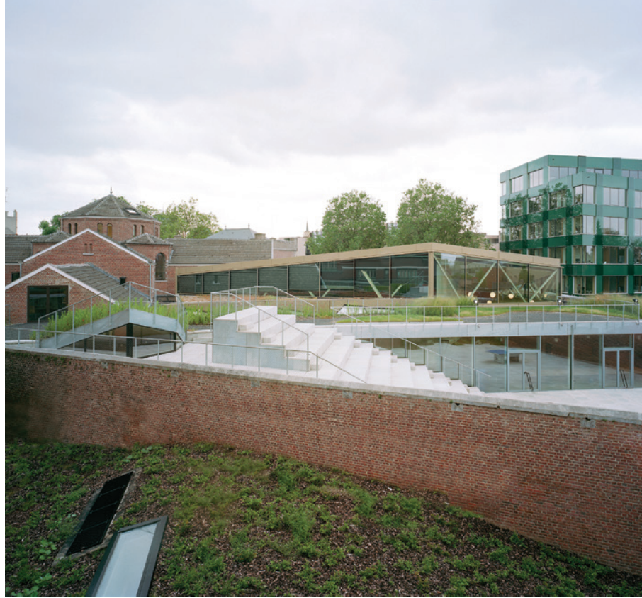
Buitenauditorium – agora – Rectoraat
