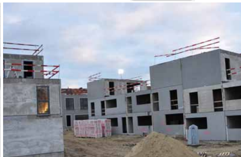
Montage van de geprefabriceerde elementen
