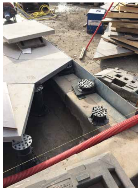
Aansluiting met de betegeling op volle grond
