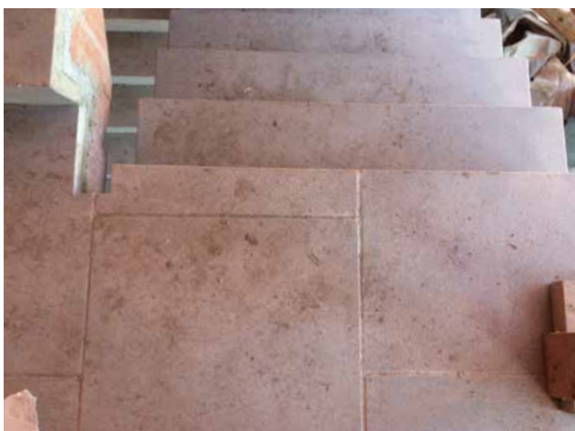
Trap in de toren: tegels en dektreden in architectonisch beton
