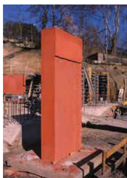
Mock-ups op de bouwplaats, schaal 1:1
