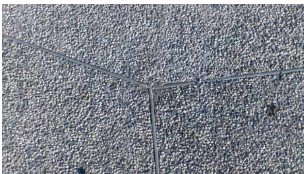
Aan elkaar gelaste voeglatten in gegalvaniseerd staal
