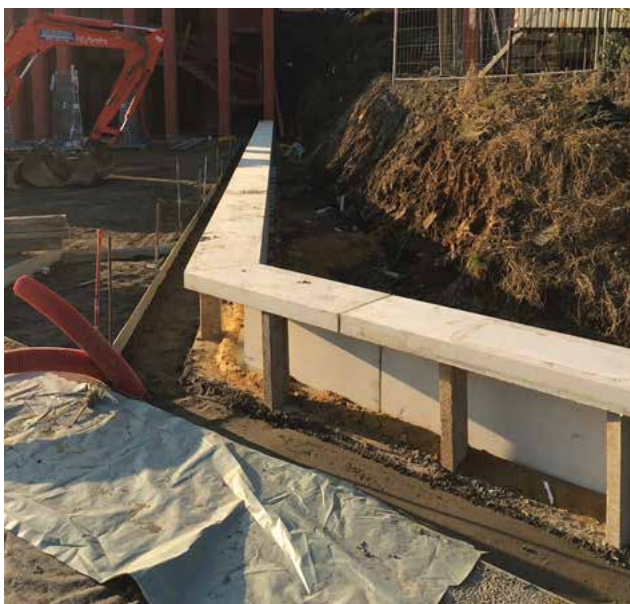
Rand van het plein: uitkragende zitbank in architectonisch beton
