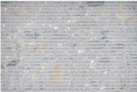
Striage longitudinal sur béton frais (Illinois, U.S.)
