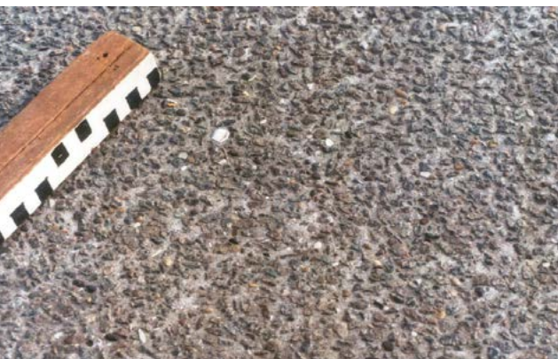
Texture d'un béton lavé 0/6,3 (Zwijndrecht, N49, 2007)
