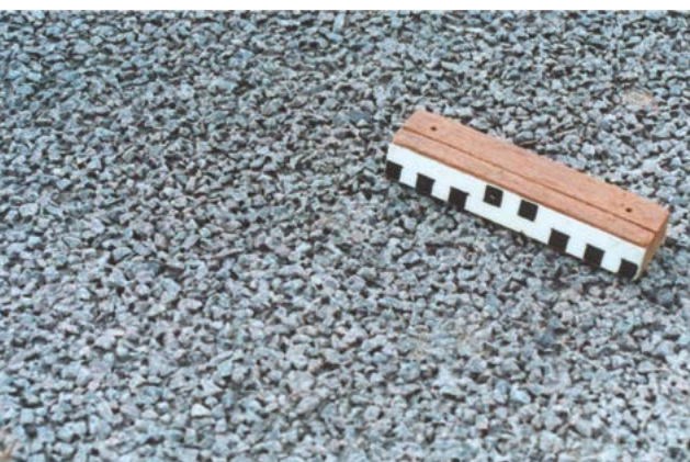
Texture d'un béton très ouvert (Herne, N255, 1996)
