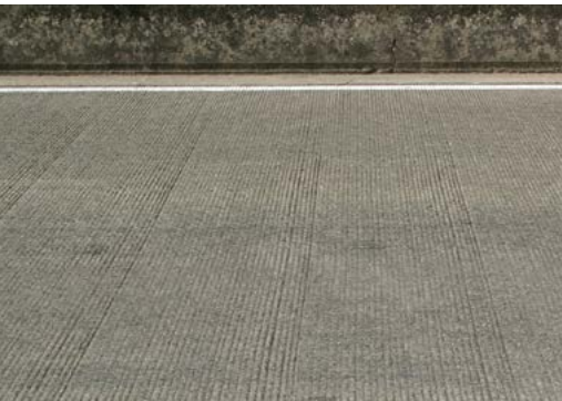
Béton strié transversalement
