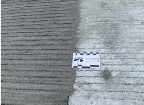
Striage longitudinal sur béton frais (Illinois, U.S.)
