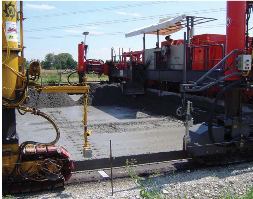
Deux machines à coffrage glissant mettant en œuvre les dalles de béton bicouches sur l'A1 (Vienne)
