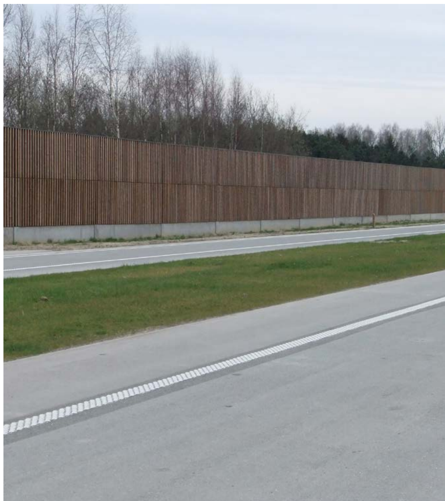
Béton bicouche peu bruyant en combinaison avec des écrans antibruit sur la N19g Geel-Kasterlee, nouvelle liaison Nord-Sud dans la Campine
