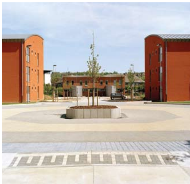
Figuur 40 – Verharding in diverse gekleurde betons voor een complex van sociale woningen in Grivegnée (Cité Demoitelle)
