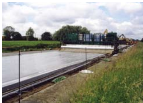
Figuur 22 – Aanbrengen van dubbellaags doorgaand gewapend beton in Estaimpuis 1 & 2 – Aanbrengen van de onderste laag (beton 0/32) 3 & 4 – Aanbrengen van de bovenste laag nat in nat (5 cm beton 0/7 of 6 cm beton 0/10 of 8 cm beton 0/14 of 8 cm beton 0/20) 5 – Verstuiven van de bindingsvertrager 6 – Plaatsen van een waterdicht membraan om het verse beton te beschermen tegen uitdroging 7 – Verwijderen van de mortel aan het oppervlak na enkele uren verharding (uitwassen) 8 – Uitzicht van uitgewassen beton, fijne macrotexuur verantwoordelijk voor het beperkte rolgeluid
