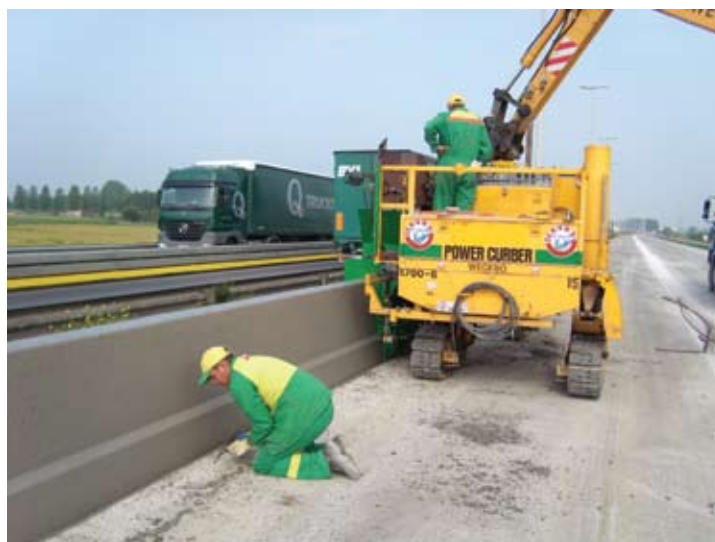
Figuur 38 – Betonning van een veiligheidsstootband (STEP profiel) op de N49/E34 in 2007
