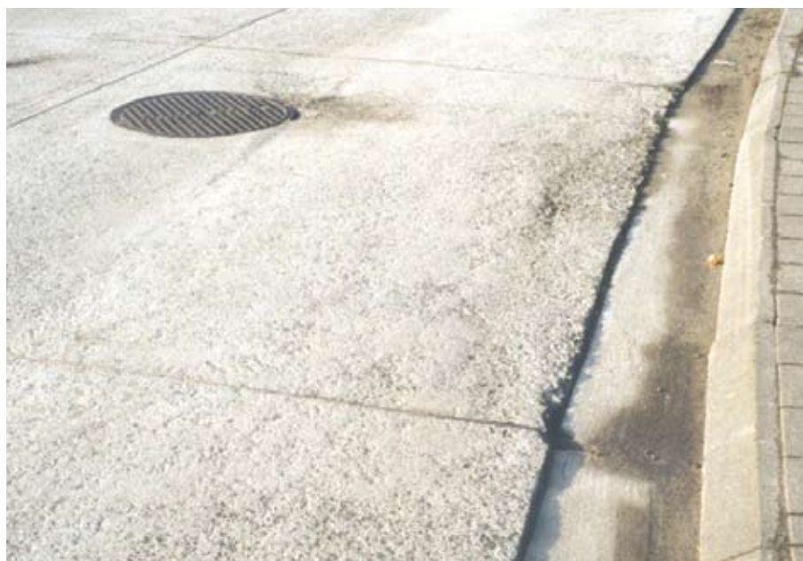
Figuur 12 – Afschilfering op een wegverharding te wijten aan de inwerking van vorst en dooizouten
