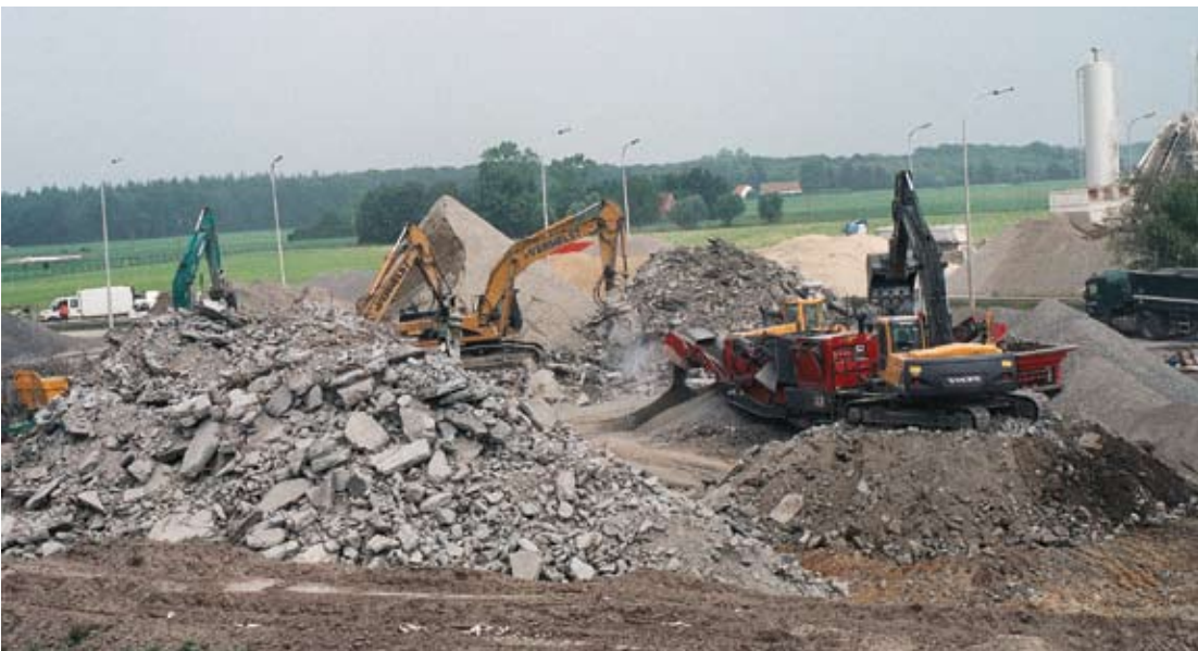
Figuur 51 – Producten afkomstig van het selectief opbreken van betonverhardingen zijn recycleerbaar. De economische druk maar ook milieuoverwegingen pleiten voor een edeler gebruik dan enkel voor funderingen
