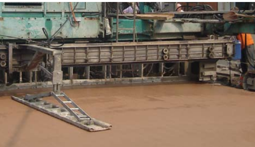
Figuur 21 - Supersmoother : lange afstrijk-balk aan de achterzijde van de machine die zich dwars over de weg verplaatst
