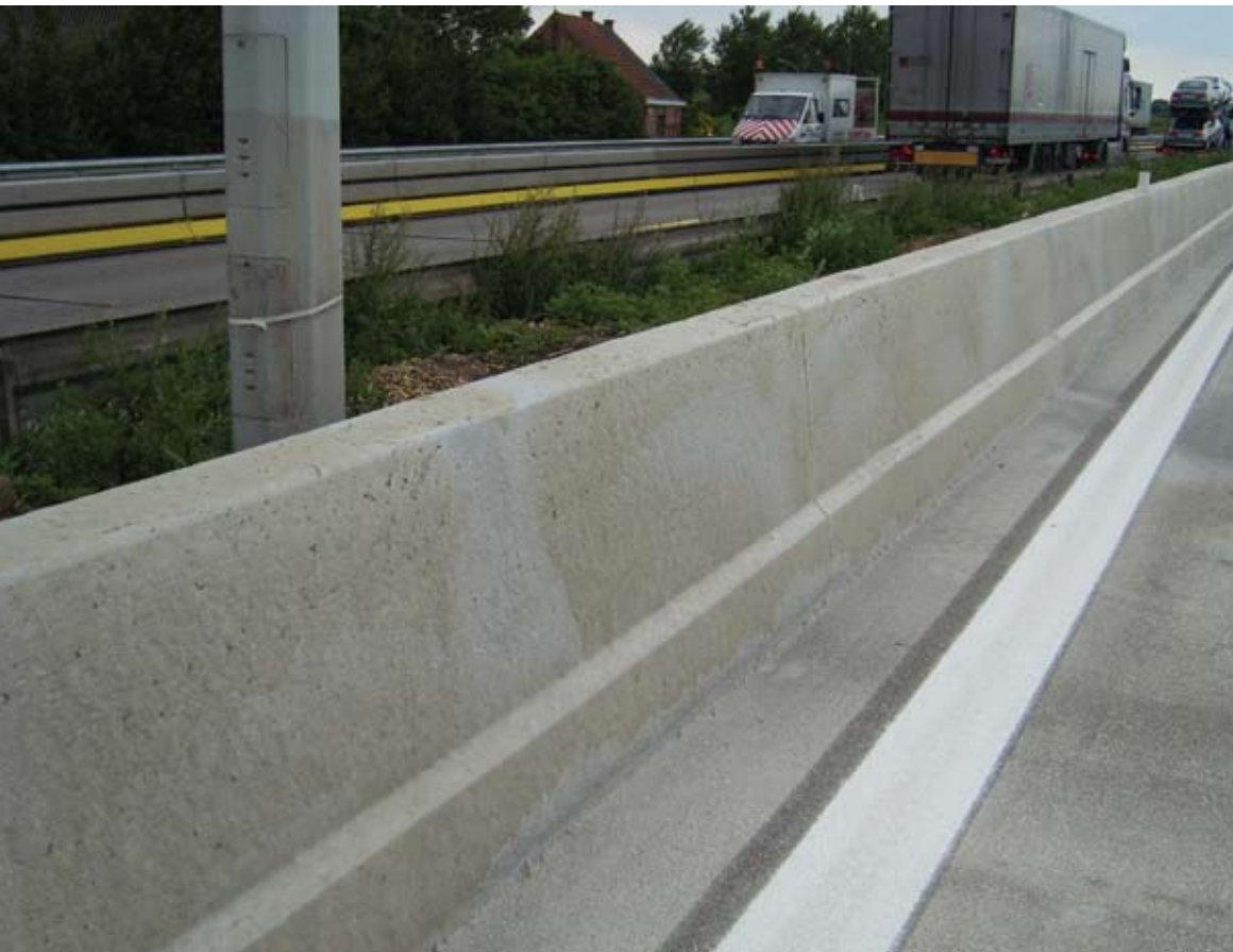
Figuur 38 – Betonning van een veiligheidsstootband (STEP profiel) op de N49/E34 in 2007
