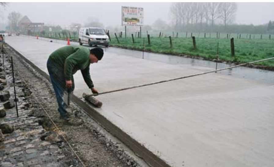
Figuur 18 – De borsteling van het betonoppervlak gebeurt door een harde borstel met aaneensluitende haren in dwarsrichting over het verse beton te halen. De duurzaamheid van de microtextuur is afhankelijk van de kwaliteit van de mortelspecie (zand - cement - water - bescherming)
