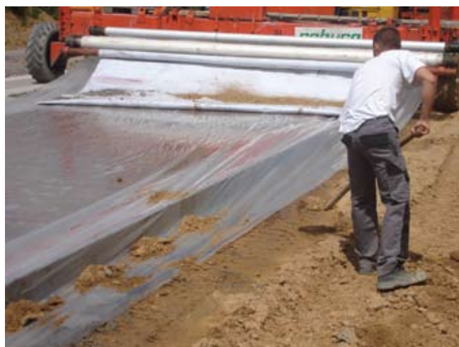
Figuur 9 – Bescherming tegen uitdroging van vers geplaatst beton is een eerste vereiste voor de kwaliteit en bijgevolg voor de duurzaamheid van de wegverharding. Deze bescherming gebeurt meestal door het aanbrengen van een waterdicht membraan (links) of de verstuiving van een nabehandlingsproduct (rechts)
