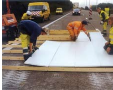
Figuur 46 – Om de ontwikkeling van de mechanische sterkte op korte termijn te bevorderen, wordt het beton dat voor de herstelling gebruikt wordt, onmiddellijk tegen uitdroging beschermd door verstuiving van een curing compound en daarna afgedekt met een paneel in geëxpandeerd polystyreen met minimum dikte van 5 cm
