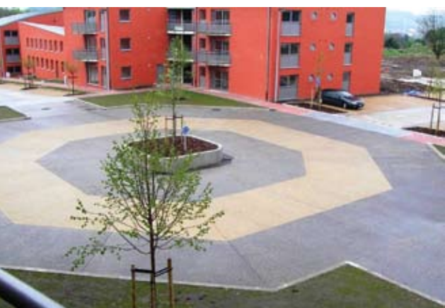
Figuur 40 – Verharding in diverse gekleurde betons voor een complex van sociale woningen in Grivegnée (Cité Demoitelle)
