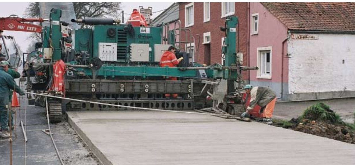
Figuur 27 – Betonneringswerken van de N29 te Perwez. De weg bestaat uit een verharding in gedevelde betonplaten met geborsteld oppervlak
