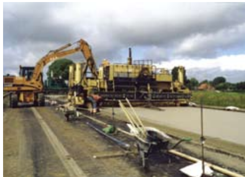
Figuur 22 – Aanbrengen van dubbellaags doorgaand gewapend beton in Estaimpuis 1 & 2 – Aanbrengen van de onderste laag (beton 0/32) 3 & 4 – Aanbrengen van de bovenste laag nat in nat (5 cm beton 0/7 of 6 cm beton 0/10 of 8 cm beton 0/14 of 8 cm beton 0/20) 5 – Verstuiven van de bindingsvertrager 6 – Plaatsen van een waterdicht membraan om het verse beton te beschermen tegen uitdroging 7 – Verwijderen van de mortel aan het oppervlak na enkele uren verharding (uitwassen) 8 – Uitzicht van uitgewassen beton, fijne macrotexuur verantwoordelijk voor het beperkte rolgeluid
