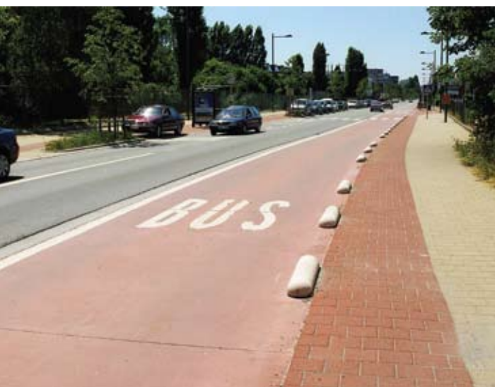
Figuur 16 – Wegverhardingen in gekleurd beton zijn multifunctioneel : publieke ruimtes, fietspaden, rijbanen voor bus of tram, ...
