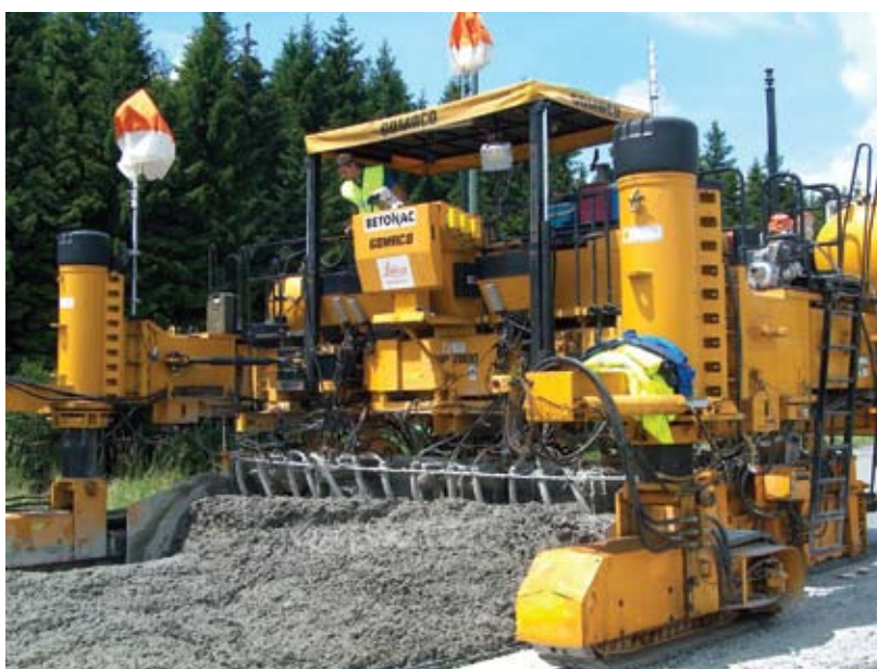
Figuur 25 – Heraanleg van de autosnelwegen E411 en E25 in de provincie Luxemburg met een doorgaand gewapend beton 0/32
