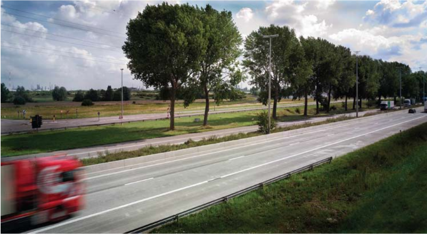
Figuur 50 – Een eerste belangrijke toepassing in België van beton op basis van gerecycleerde granulaten voor de aanleg van een wegverharding vond plaats in 2007-2008 bij de vernieuwing van een sectie van 3 km van de N49/E34 ter hoogte van Zwijndrecht/Melsele. Het gaat hier om een tweelaags wegdek in doorgaand gewapend beton met gebruik van gerecycleerde granulaten in de onderste laag. In dit geval werden alle granulaten 6/20 en 20/32 vervangen door gerecycleerd beton 6/20 en 20/32 afkomstig van het selectieve opbreken van de bestaande verharding waardoor een recyclagepercentage van ongeveer 60 % van het totale inerte skelet van het beton 0/32 werd bereikt
