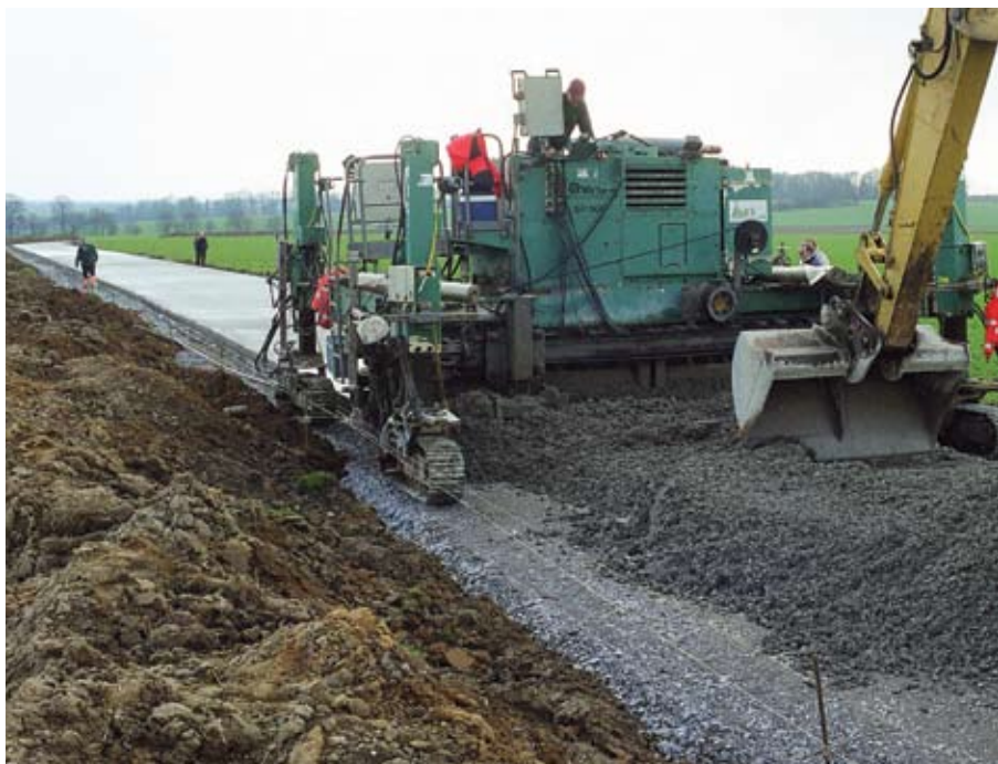
Figuur 29 – Betonning van een ruilverkavelingsweg te Fexhe-le-Haut-Clocher
