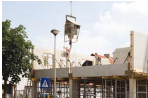
Fig.54-55 : Plaatsing van geprefabriceerde elementen en gieten van stortklaar beton (arch. WIT / Bogdan & Van Broeck / LAVA, foto's André Nullens)
