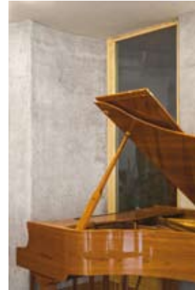
Fig. 44 : Ruw oppervlak of textuur met holtes om de nagalmtijd te verkorten (arch. M. Schepens)
