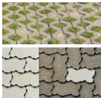
Fig. 49 : Grasbetontegels en doorlatende straatsteenverharding
