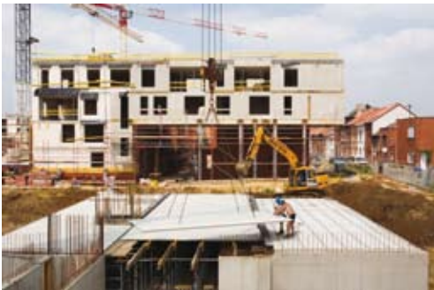
Fig.54-55 : Plaatsing van geprefabriceerde elementen en gieten van stortklaar beton (arch. WIT / Bogdan & Van Broeck / LAVA, foto's André Nullens)
