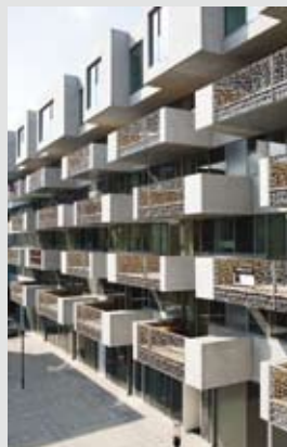
Fig. 40 : Wonen in de buurt van het stadscentrum en in alle comfort : ruimte, uitzicht, licht, akoestiek... (arch. BOB361)
