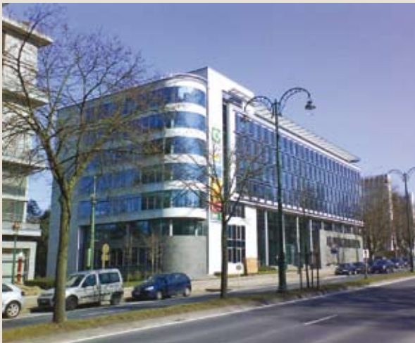
Fig. 32 : Solaris kantoorgebouw, Brussel (arch. ASSAR)
