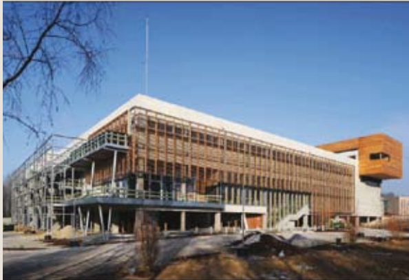
Fig. 60 : Algemeen beeld van het gebouw (bron: AWAA for CW Architects)
