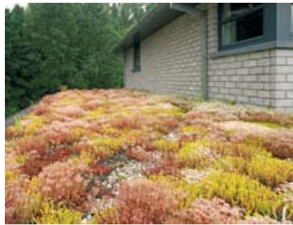
Fig. 50 : Voorbeeld van een extensief dak (bron: Floradak)
