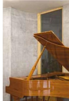
Fig. 44 : Texture rugueuse/caverneuse pour limiter le temps de réverbération (arch. M. Schepens)
