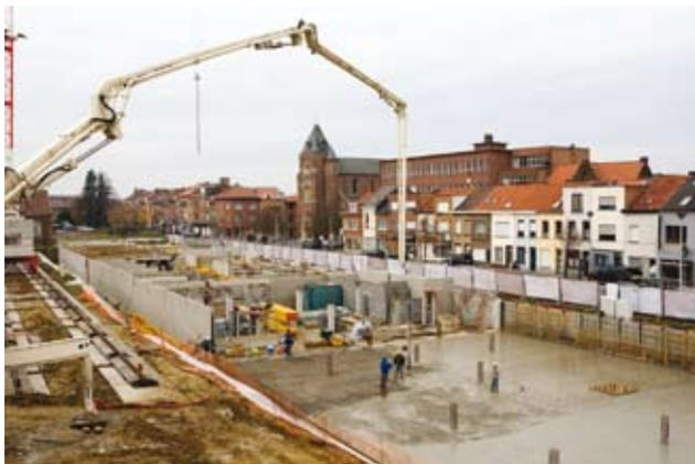
Fig. 58 : Pompage du béton frais, facilitant sa mise en oeuvre sur des chantiers vastes et/ou difficilement accessibles
