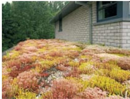
Fig. 50 : Vue d'une toiture extensive
