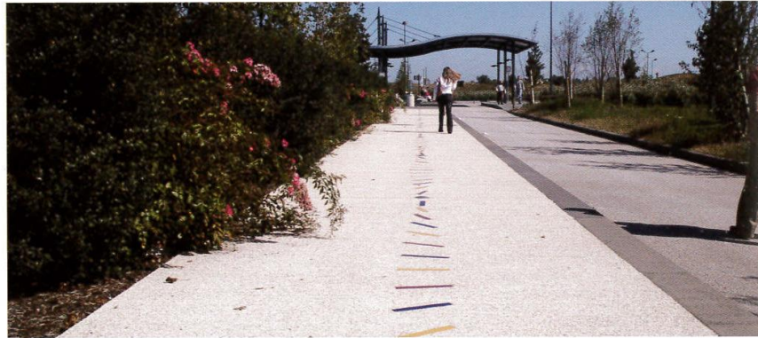
Le béton incrusté permet de varier à l'infini le style d'un parvis ou d'une allée piétonne. Les éléments constitutifs du décor sont introduits dès la fabrication du béton ou « cloutés » sur la surface au moment du chantier.
