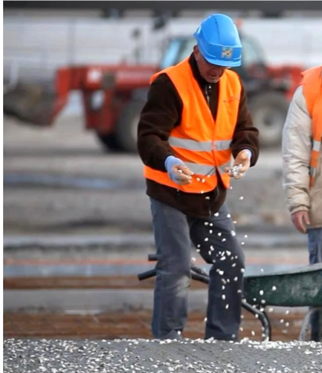
Le béton incrusté permet de varier à l'infini le style d'un parvis ou d'une allée piétonne. Les éléments constitutifs du décor sont introduits dès la fabrication du béton ou « cloutés » sur la surface au moment du chantier.
