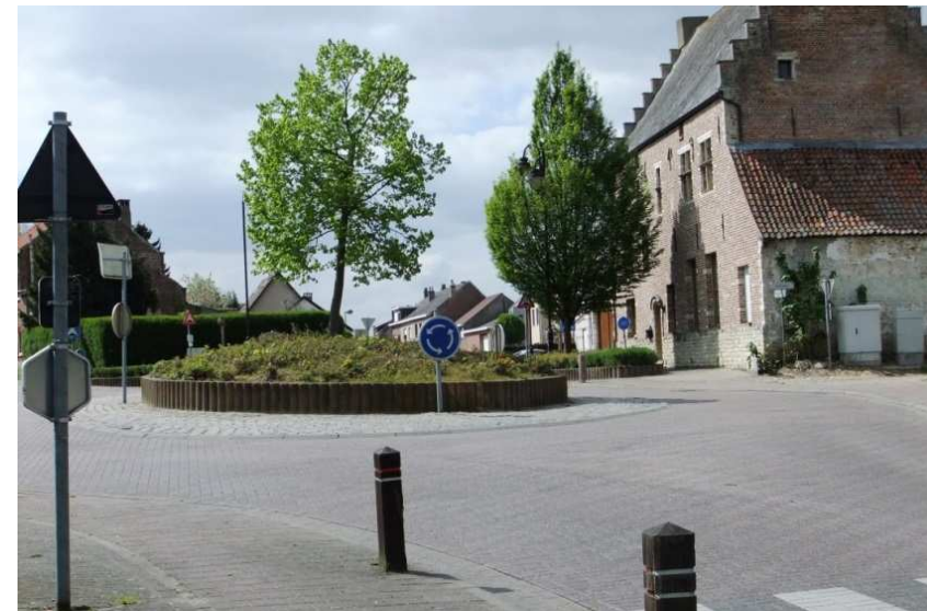
Everberg : lokale rotonde in betonstraatstenen
