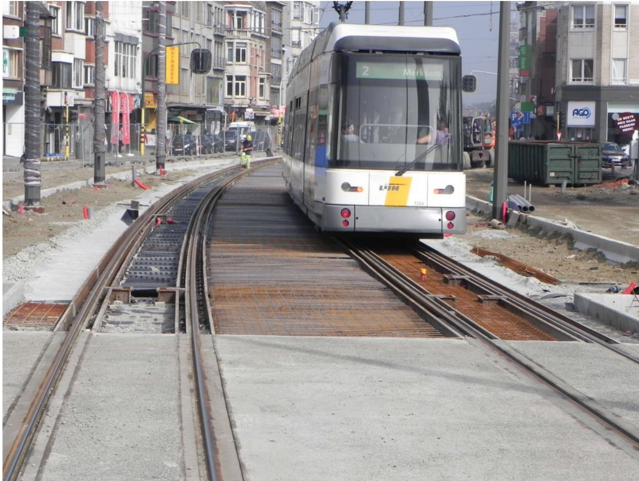
Passage tram , hier zelfs bij plaatsen wapening
