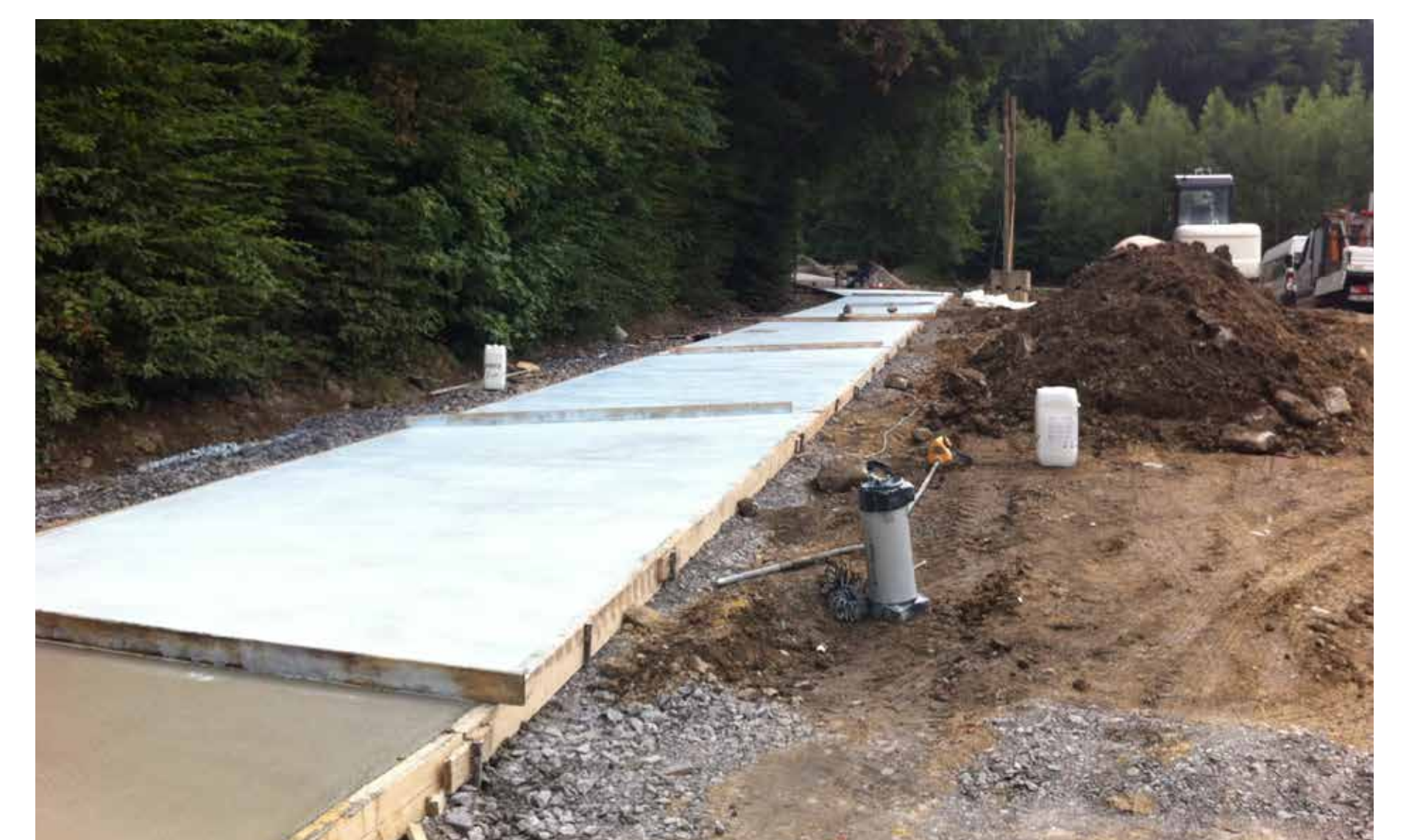
Désactivation du béton
