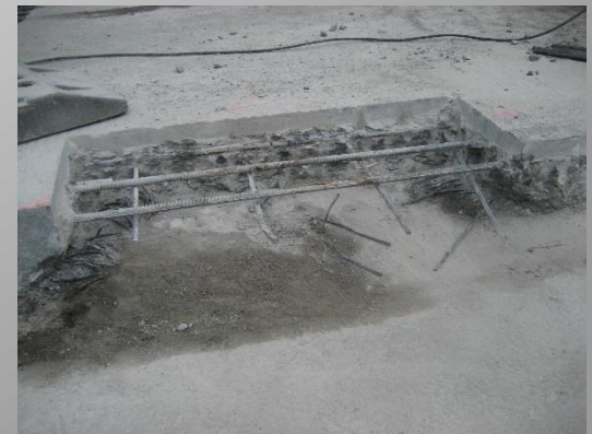
Mesure corrective = démolition localisée
