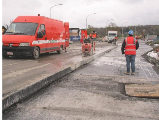
Mesure corrective = resciage du BAC pour retrouver une face saine
