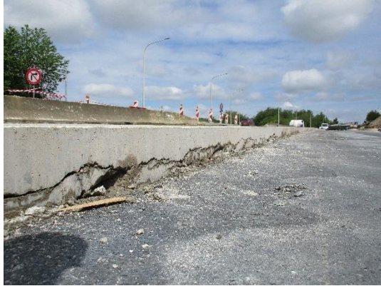
Face hétérogène du BAC 1970: vibration insuffisante lors de sa mise en œuvre (effet de bord)
