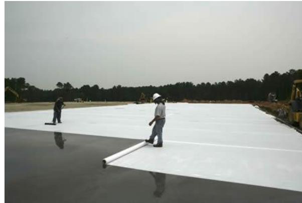
Couverture par bâches
