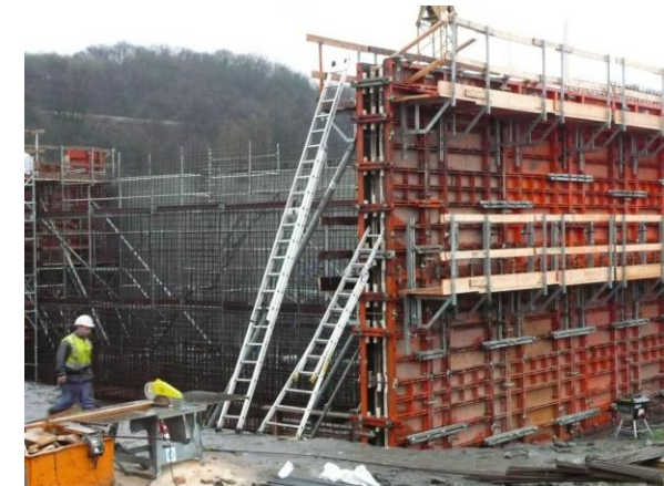
Maintien du coffrage en place
